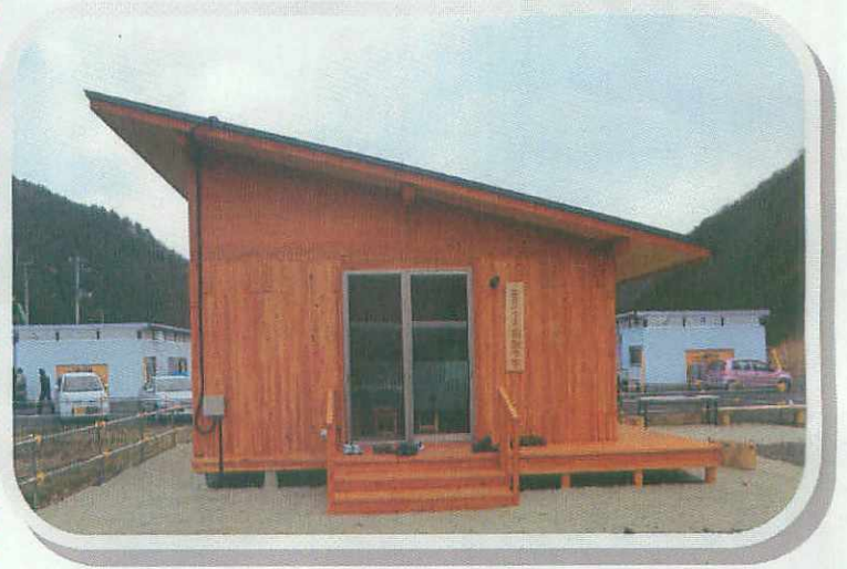
「エコハウスおおつち」全景(奥に小槌第4仮設団地)
