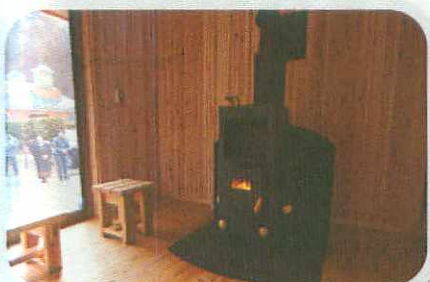
電気を使わないエネルギー自立型のペレットストーブ
