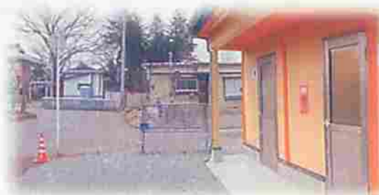
整備された「三ツ石トイレ」
