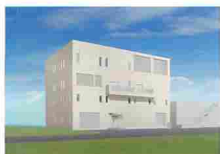
中川原終末処理場簡易水処理施設（ポンプ棟） 平成24年度完成予定
