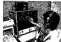
緊急割り込み放送装置(災対本部事務局等に設置)
