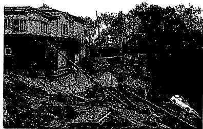
団地の外周道路が大規模に崩落し、住宅が被災
