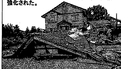
建物の新旧により倒壊が異なる。
