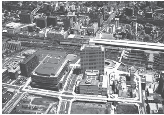
未利用の土地が目立つ盛岡駅西口
