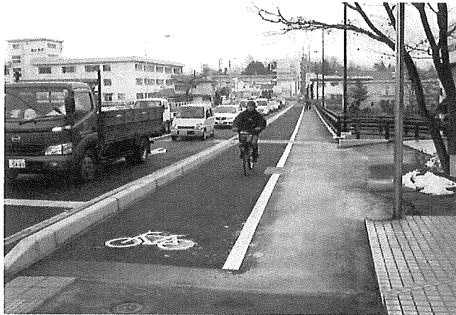
歩道に自転車通行帯を設置した事例（館坂橋）
