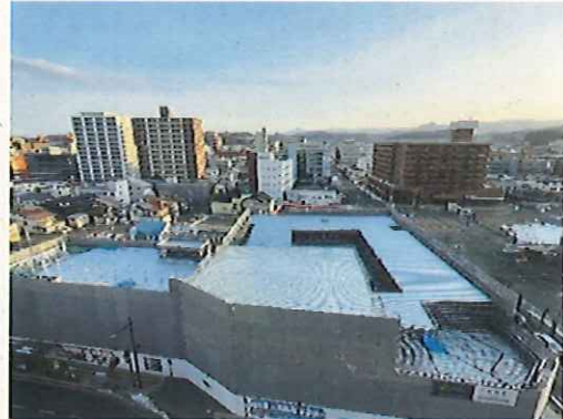
【鉄骨建て方後の状況（令和4年3月1日時点）】
