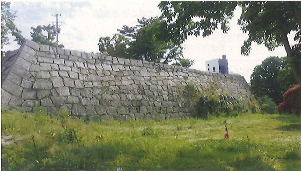
三ノ丸北西部石垣(着工前)
