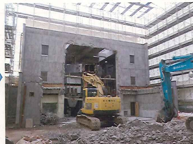
③【建屋解体(地上部)：焼却炉等機器解体】 実施時期：令和3年5月～6月
