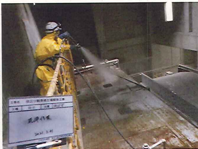
②【ダイオキシン類除染：高圧洗浄】 実施時期：令和3年3月～5月
