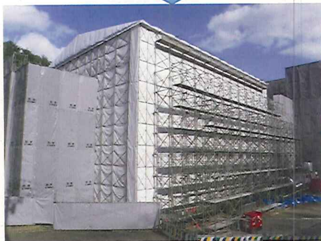
①【ダイオキシン類除染：仮設養生シート】 実施時期：令和3年3月
