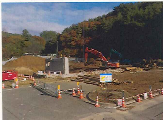
⑤【建屋解体(地下部)：南側全景】 実施時期：令和3年8月～12月
