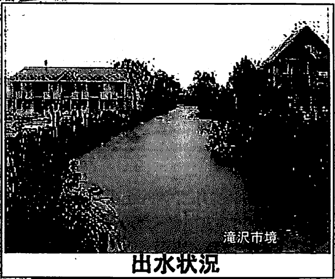
出水状況 木賊川 遊水地・河川改修要望 (北上川合流点～滝沢市境)
