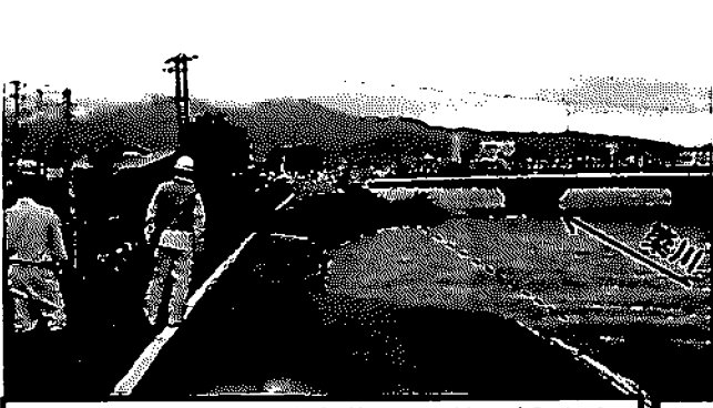
H14.7洪水による堤防崩落現場(築川橋付近)
