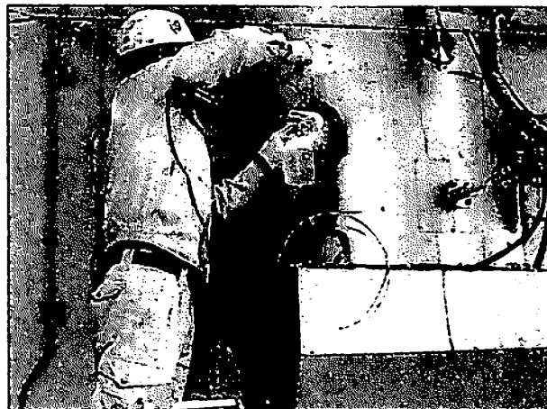
煙突への出口での検査器の取り付け
