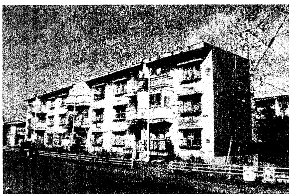
既存：青山三丁目アパート7号館
