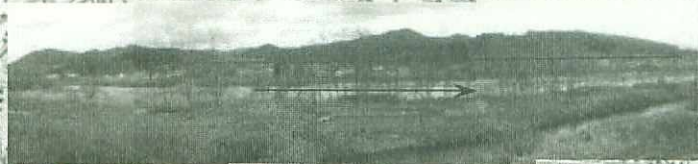
北上川 乙部地区
