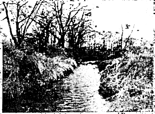
南川 築堤護岸 (北上川合流点～国道4号)
