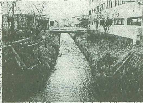
木賊川 分水路・遊水池・河川改修 (北上川合流点～滝沢村境)
