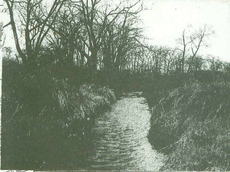
みなみかわ 南川 築堤護岸 (北上川合流点～国道4号)
