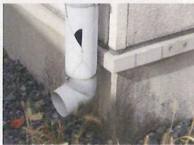
雨水排水管 破損
