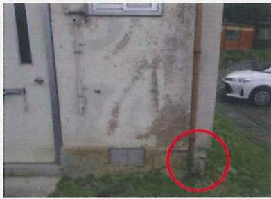
北面外壁基礎 鉄筋露出
