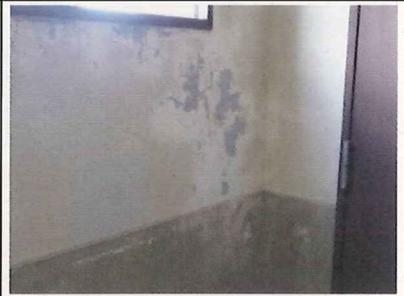
階段室 壁ひび割れ、塗装剥離
