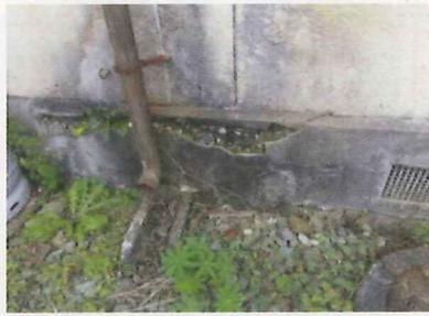
北面外壁基礎 破損
