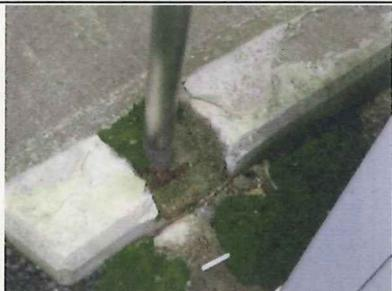
スロープ手すり基礎 鉄筋露出
