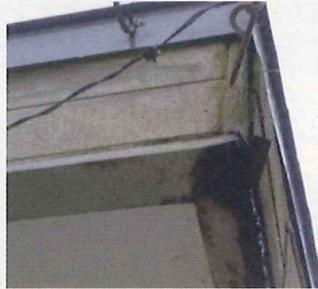
西面外壁軒下 腐食・破損
