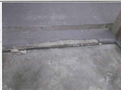
屋外階段縦ぎ目 破損
