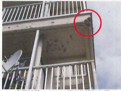
南面外壁 ベランダ天井端部欠損
