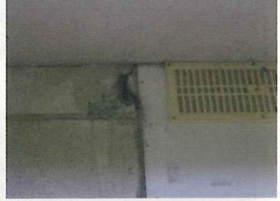
南面外壁 鉄筋露出
