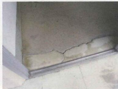
階段室入口 コンクリートひび割れ
