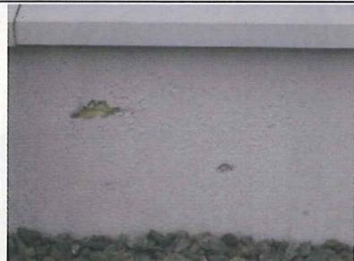
南面外壁基礎部 外断熱材損傷
