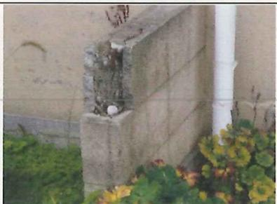
北面外壁間仕切り壁 鉄筋露出
