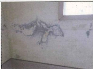
階段室壁面 ひび割れ・剥離
