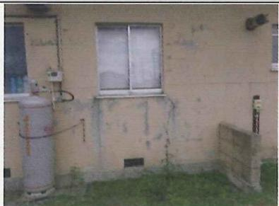
北面外壁 ひび割れ・剥離
