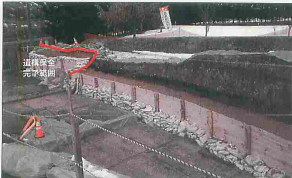
平成26年2月22日 遺構保全埋戻し完了 (南東から)
