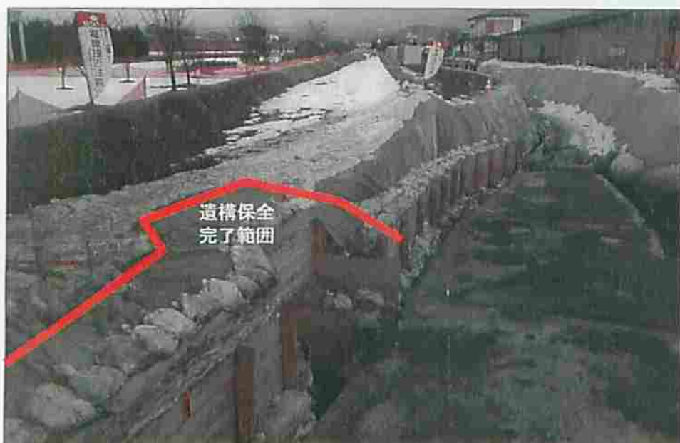
平成26年2月24日 シート養生完了状況 (西から)
